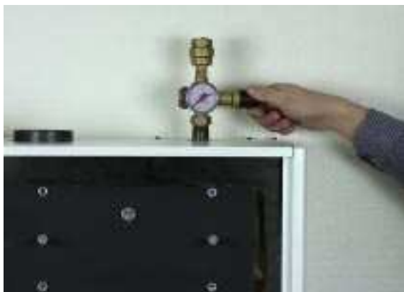
1. Nekajkrat letno obrnite varnostni ventil, da bi preverili njegovo delovanje.
